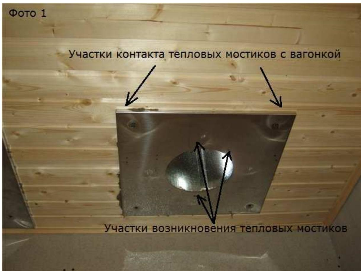
Подобные тепловые мостики очень опасны, и ведут к непредсказуемым последствиям. Следующее фото сделано лишь после 10 растопок с момента установки дымохода.
